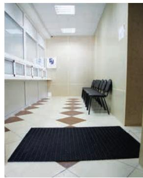
Во избежание травм, вызванных падением на скользких поверхностях, на прилегающей территории, на входе в здание, в ряде мест внутри здания (скользкий пол) устанавливаются противоскользящие покрытия.
